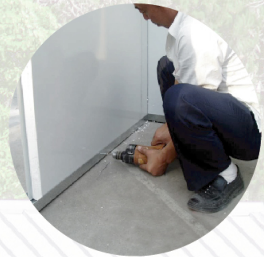
3- FIJACIÓN DE PANELES
