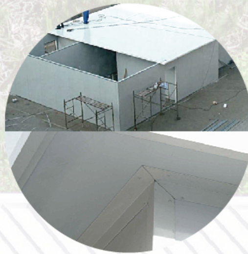
5- INSTALACIÓN DE TECHOS Y TERMINACIONES
