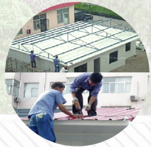
6- INSTALACIÓN DE TECHO A 2 AGUAS SOBRE PANEL TÉRMICO
